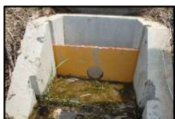
【流量調整板設置状況】
